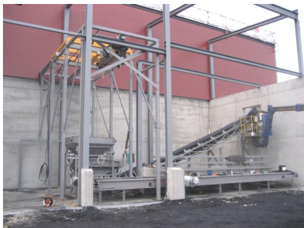
Anläggning håller på att färdigställas.
