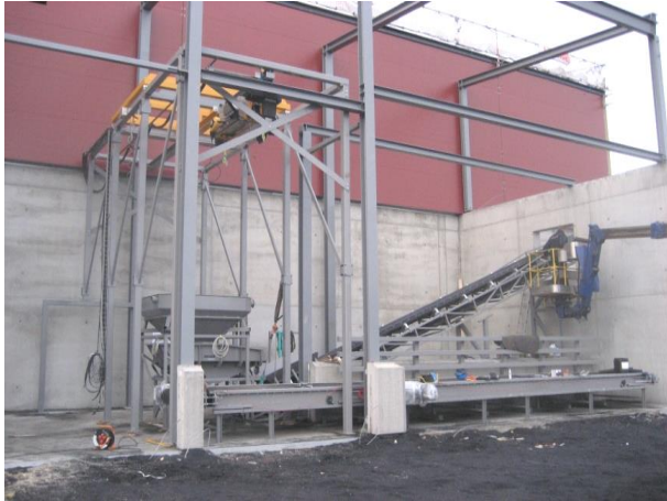
Anläggning håller på att färdigställas.
